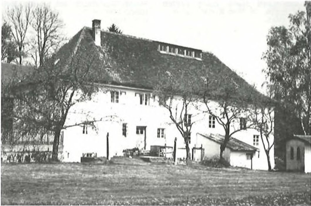
Untere Mühle Walleshausen (rechts im Bild die ehemalige Heimatstube)
