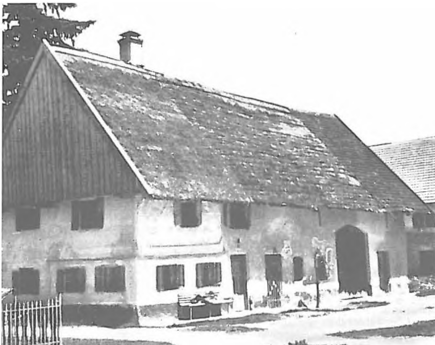
Erpfting: Hs. Nr. 73 – Spreigl – 17. Jhdt. – 1960 abgebrochen
