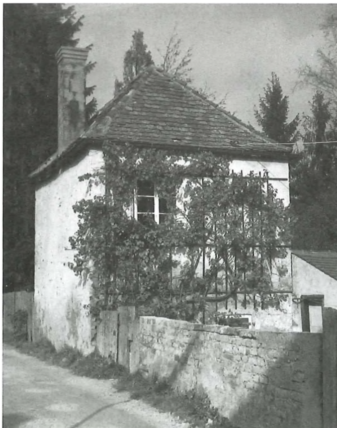
Eines der alten Gartenhäuser (heute abgebrochen) an der Bischof-Riegg-Straße im sogenannten Apothekergarten.
