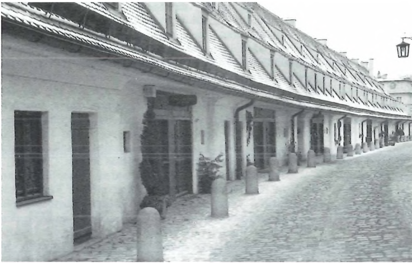
Neuer Salzstadel nach der Sanierung.
