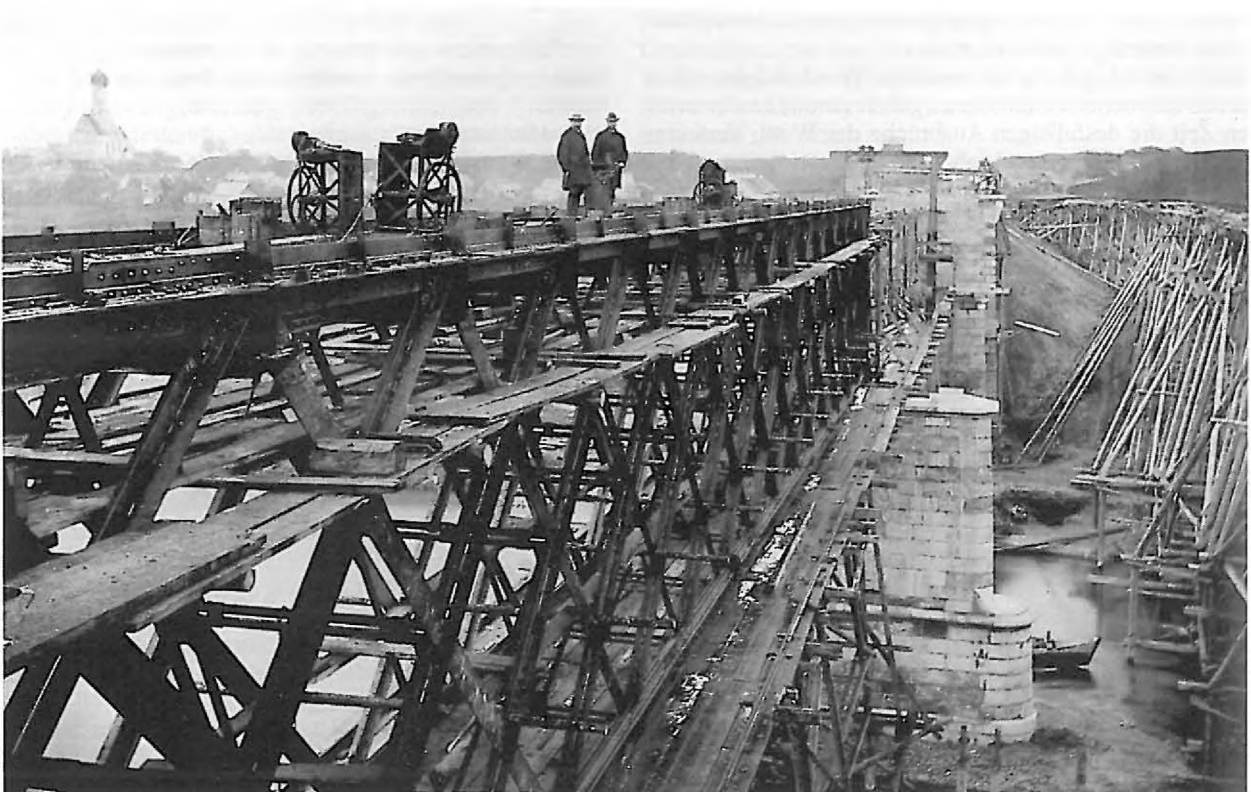
Abb. 1: Die Brückenbaustelle am 12. November 1872, ein halbes Jahr vor ihrer Fertigstellung. Mit Hilfe einer Feldschmiede wird der Fachwerküberbau vernietet. Am rechten Bildrand ist das Transportgerüst (vgl. auch Abb. 3) zu erkennen, links oben die Pfarrkirche St. Johann in Kaufering.
