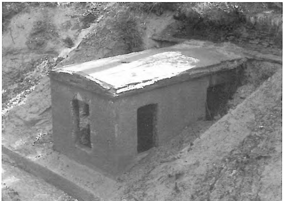
Das alte Maschinenhaus bei leerem Staubecken (März 1990)
