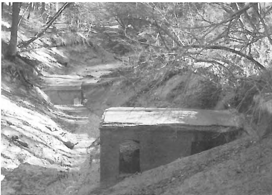
Altes Maschinenhaus mit Stützmauer bei leerem Staubecken (März 1990)
