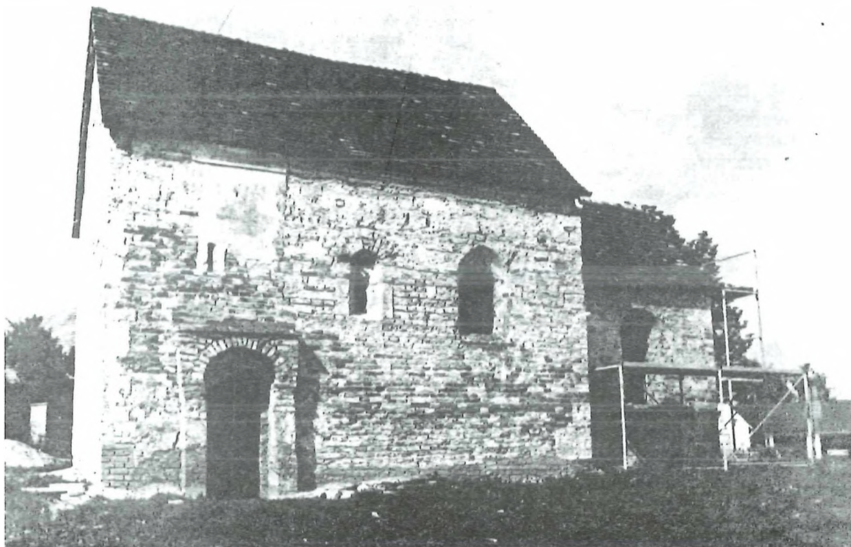
Rupertkapelle während der Renovierung im August 1981. Erbaut aus wechselnden Ziegel- und Tuffsteinschichten: Spolien aus Ruinen der Römerzeit(?)
