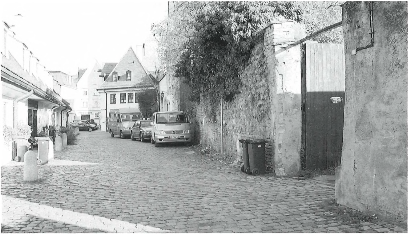
Alte Stadtmauer aus Nagelfluh an der Hinteren Salzgasse, links der Salzstadel
