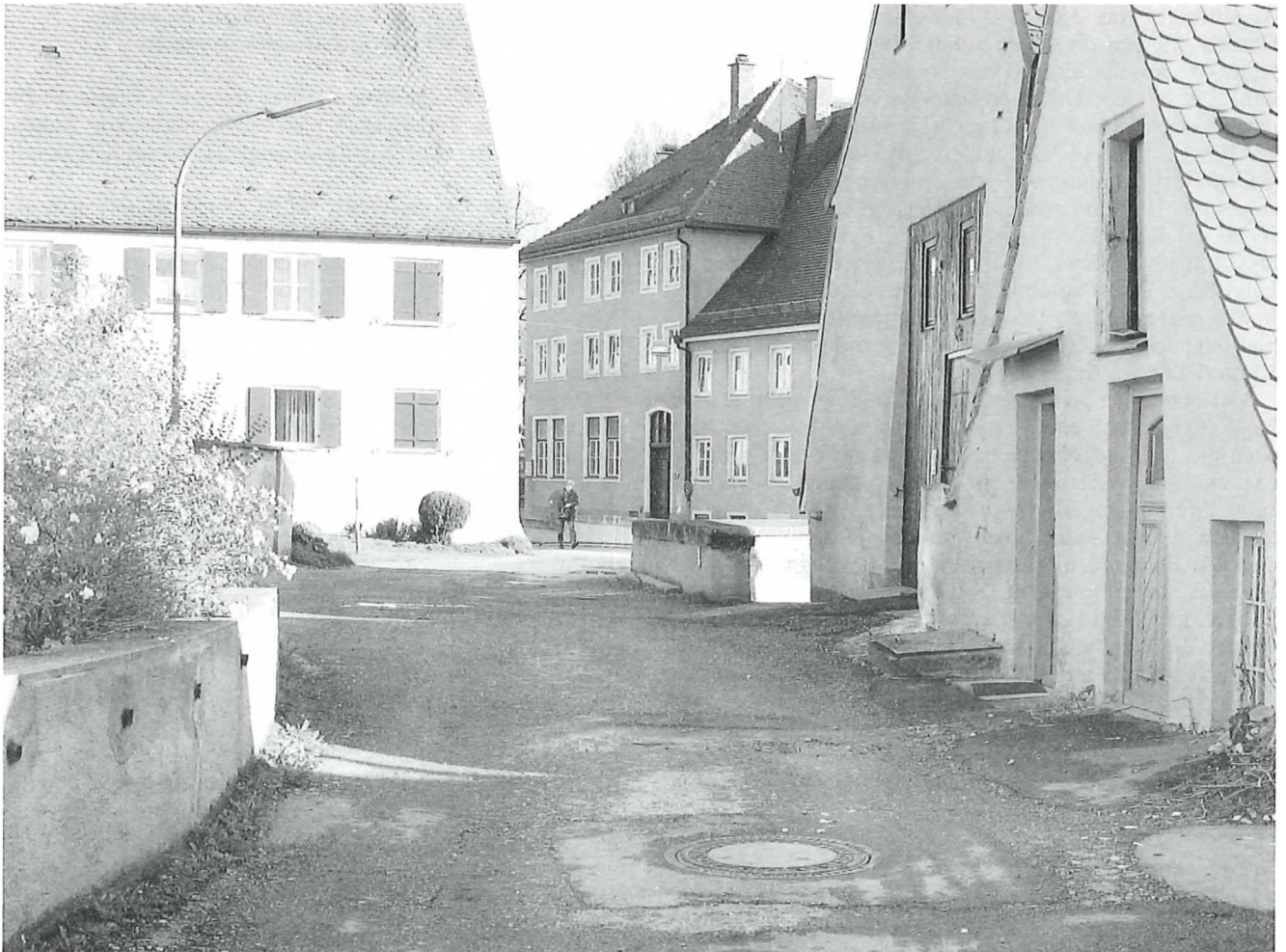
Die Jesuitengasse liegt so hoch über der Alten Bergstraße, dass deren Häuser von hier aus einen Zugang ins Dachgeschoss haben
