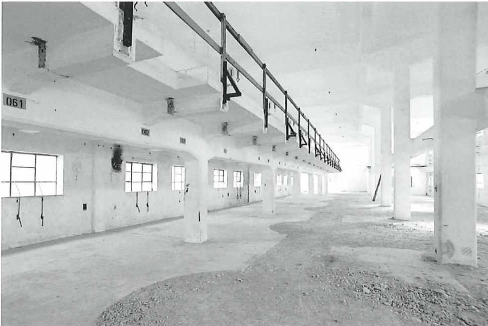
Holländergebäude im Jahr 2001. Am Boden ist die Lage der Holländer noch gut ablesbar:
