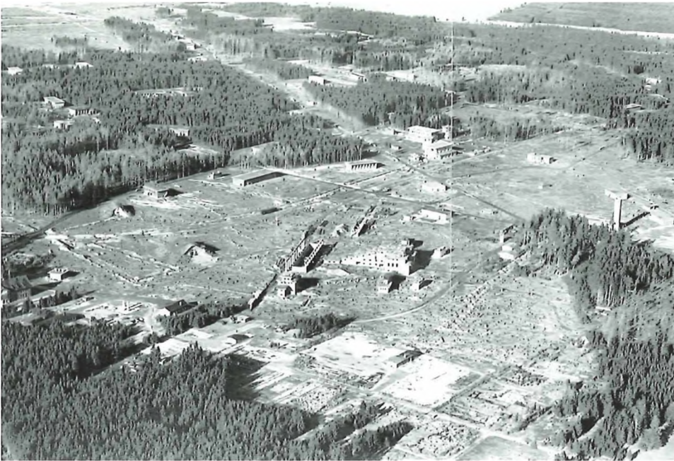
Luftaufnahme um 1947. Um das Gelände zu entarnen, hatten die Amerikaner den Wald abholzen und den Bewuchs von den Flachdächern abschleiben lassen. Man sieht in der Mitte der Lichtung das Kraftwerk mit Bekohtung, Entaschung und Rauchgasreinigung, links davon die erdbedeckten Gewölbebauten von Turbinenhaus und Schaltheaus.
