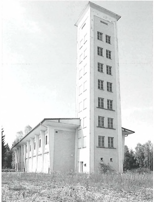
Bild rechts: Eines der auffälligsten Gebäude auf dem Gelände war das Feuerwehrhaus. Der Bau bestand aus dem Schlauchturm, einer großen Garage und Wohnräumen für die Mannschaft. Die Aufnahme stammt aus dem Jahr 2001, heute ist das Gebäude abgebrochen
