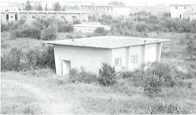
Diese Aufnahme von 1951 zeigt die typischen Stahlbeton-Skelettbauten der Fabrik. Im Vordergrund ist dies ein Lagergebäude, im Hintergrund stehen Kocher und Holländergebäude aus der Produktionslinie.
