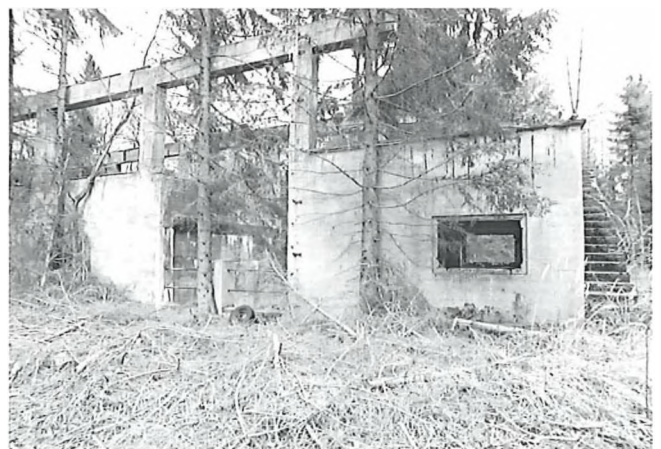
Der Frauenwald erobert sich das Gelände zurück. Diese Aufnahme aus dem Jahr 2001 zeigt die Kranlaufbahn der Entaschung des Kraftwerks.
