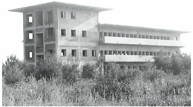
Eines der beiden Nitriergebäude in einer Aufnahme von 1951. Hier sollte aus Holzzellulose und Säure Nitrozellulose entstehen. Das Gebäude war durch eine Vielzahl von Rohrleitungen mit den vor- und nachgeschalteten Produktionsgebäuden verbunden. Die umlaufenden Balkone dienen als Fluchtmöglichkeit für die Arbeiter, da die Nitrierung sehr brandgefährlich ist.
