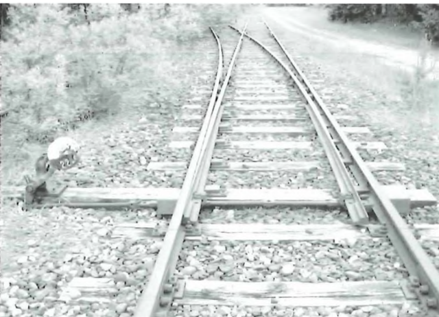
Abb. 1: Die Weiche 22 verbindet westlich der Laderampe F 915 das Hauptgleis mit dem Nebengleis, das schon seit längerem stillgelegt ist und daher allmählich mit Jungwald zuwächst.
