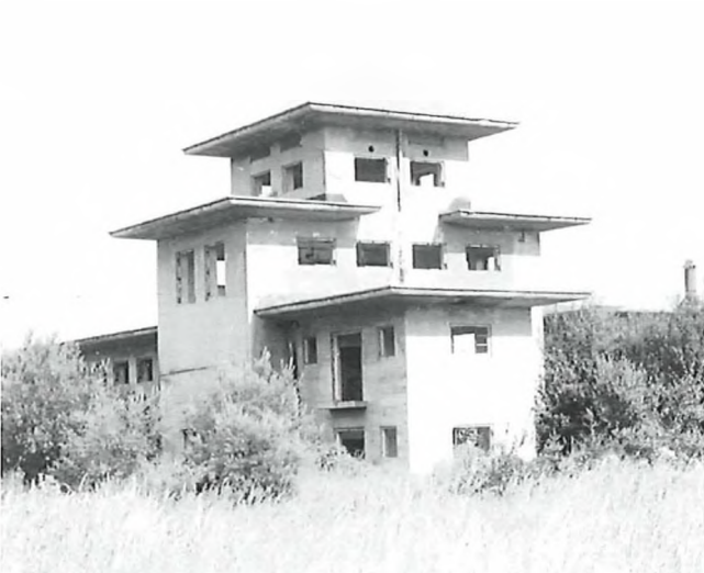
Eines der beiden Gebäude zur Wasseraufbereitung in einer Aufnahme um 1951. Hier sollte das Speisewasser für die Kessel des Kraftwerks entkalkt werden. Das Gebäude besteht vollständig aus Stahlbeton. Zur Tarnung ist das Dach in mehrere, abgetrepte Flächen zerlegt, die Bewuchs tragen sollten.
