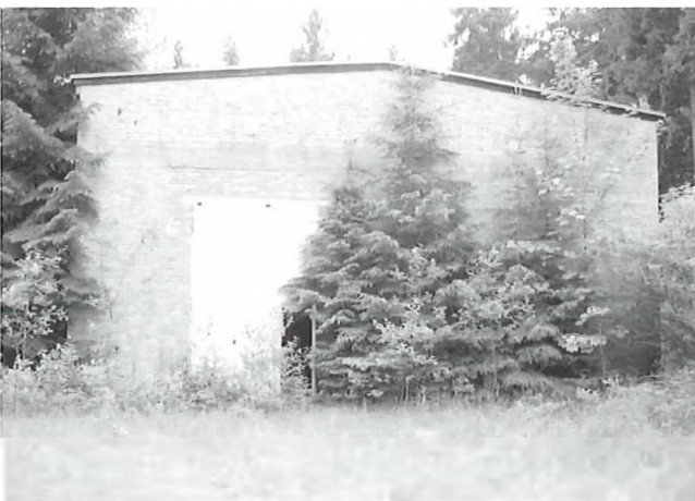
Abb. 3: Der ehemalige Lokschuppen der DAG im Frauenwald wurde nach dem Rückbau des Schienenanschlusses von der Bundeswehr offenbar als Lagerhalle genutzt
