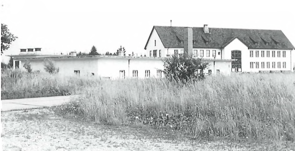
Gebäude an der Iglinger Straße um 1951. Im Vordergrund steht die ehemalige Werksrettungsstelle, die zu diesem Zeitpunkt als Wohngebäude genutzt wurde. Sie wurde später mit einem flachen Satteldach versehen und ist heute abgebrochen. Im Hintergrund sieht man das repräsentative Verwaltungsgebäude, das heute ebenfalls nicht mehr steht.
