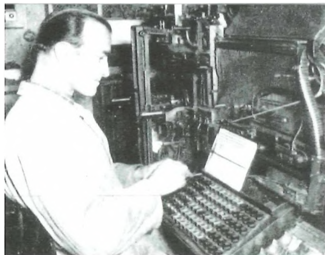
Zeilensatz an der mechanischen Linotype-Bleisetzmaschine. Josef Schmid war der einzige Setzer mit Englischkenntnissen, der die Manuskripte lesen und perfekt abtippen konnte.
