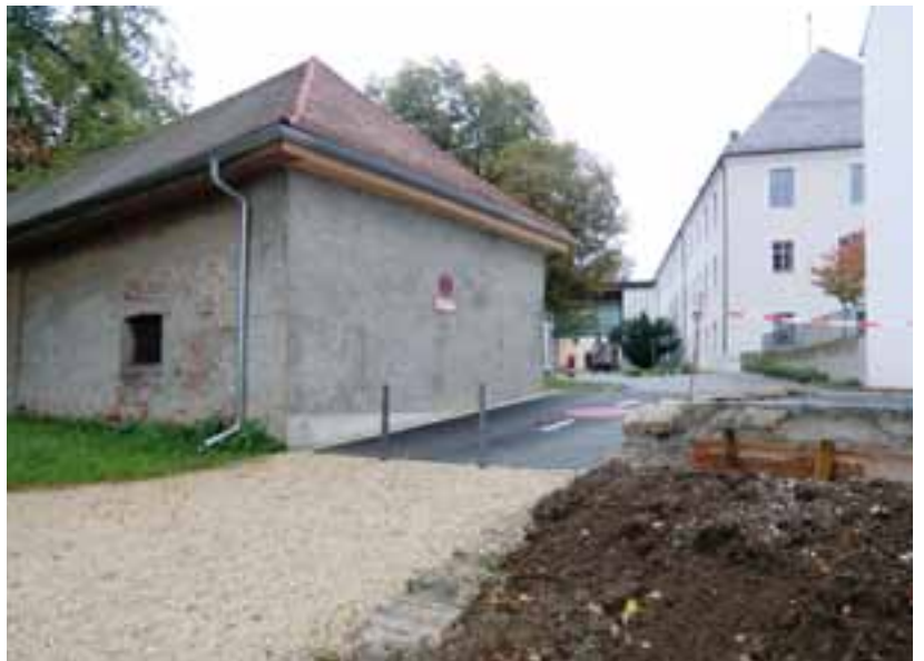
Abb. 3 oben : Zustand während der Bauphase. Bild zeigt freige- legtes Straßenbe- leuchtungskabel (Quelle: Stadt- bauamt)
