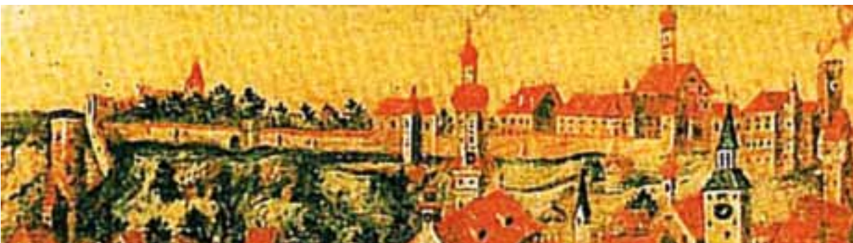
Abb. 3e: Von 1745 entspricht das Votivbild der Ansicht von 1628, nur hat hier die Stadtpfarrkirche einen barocken Zwiebelturm (seit 1699) und der Wasserturm vor dem Gartenhaus ist zu sehen. (StML, Inv. Nr. 46; vermutlich aus der Leonhardikapelle)
