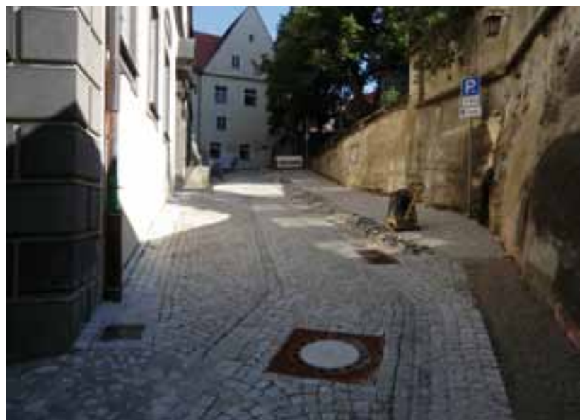
Abb. 4 mitte: Feuerwehruzufahrt beim Hl. Geist- Spital (Quelle Stadt- bauamt)
