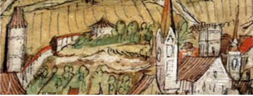
Abb. 3a: Karte zum Burgfrieden von 1557/59: Die kahlen Hänge des immer wieder abrutschenden Leitenberges sind zu erkennen. Die Stadtmauer führt im Norden vom Dachlturm den Hang hinauf, wo der Pulverturm als großer, runder Turm mit spitzem Dach zu erkennen ist. Die Anhöhe ist grün von Strauchwerk und Bäumen. [Burgfrieden' ist ein geschützter Rechtsbereich um eine Burg oder eine Stadt miteigener Gerichtsbarkeit.] (BHStA, Abt. 1, Plansammlung 18717; StBL)
