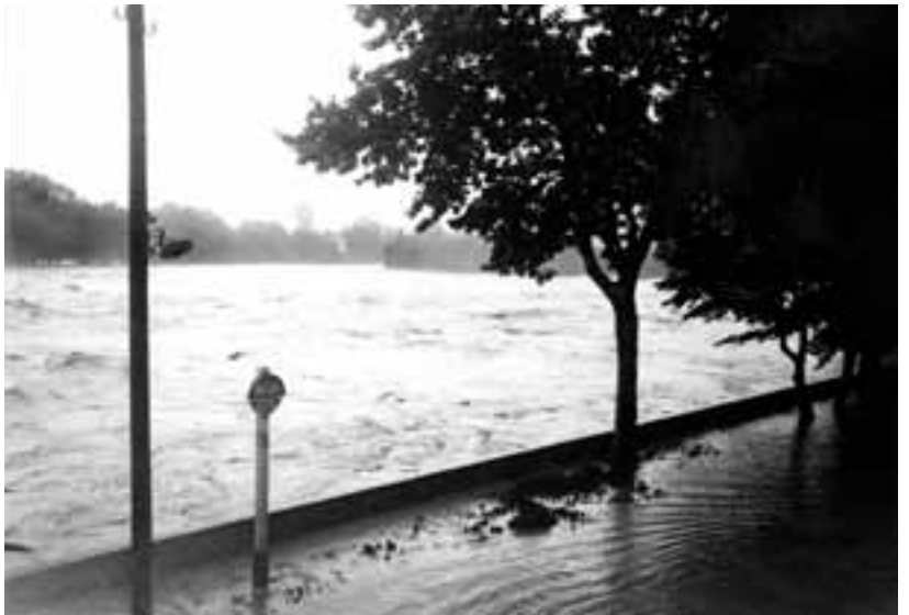
Abb. 7: Ufermauer am Peter-Dörfler-Weg
