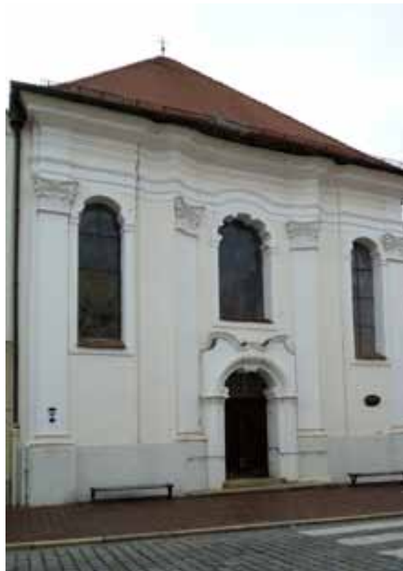
Abb. 7: Ehemalige Friedhofskirche St. Johannis im Benefizium von Simon Mayr, erbaut von Dominikus Zimmermann.
