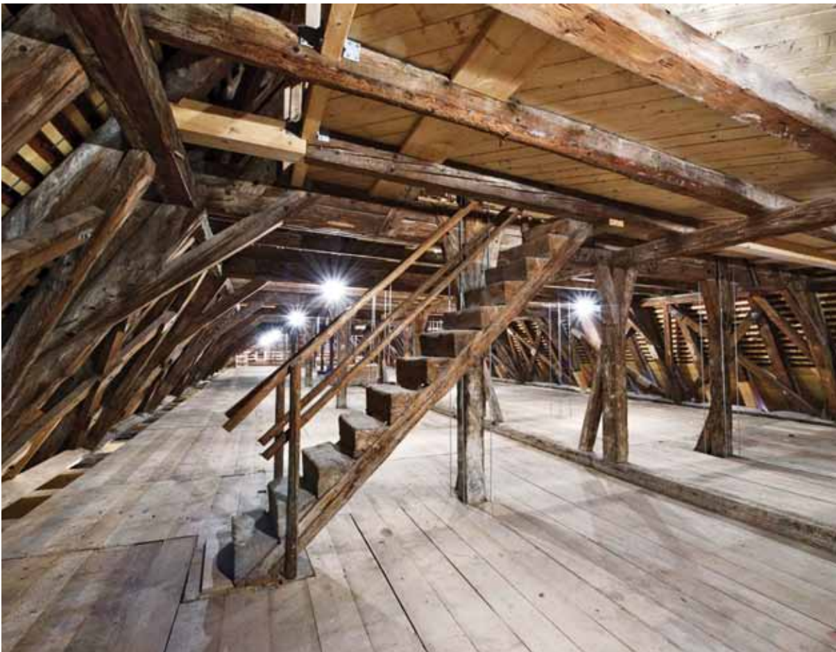
Dachstuhl nach der Sanierung, Photo Brandl
