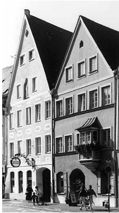
ehemaliger Brauereigasthof Unterfeigerl, 1993, linkes Haus
