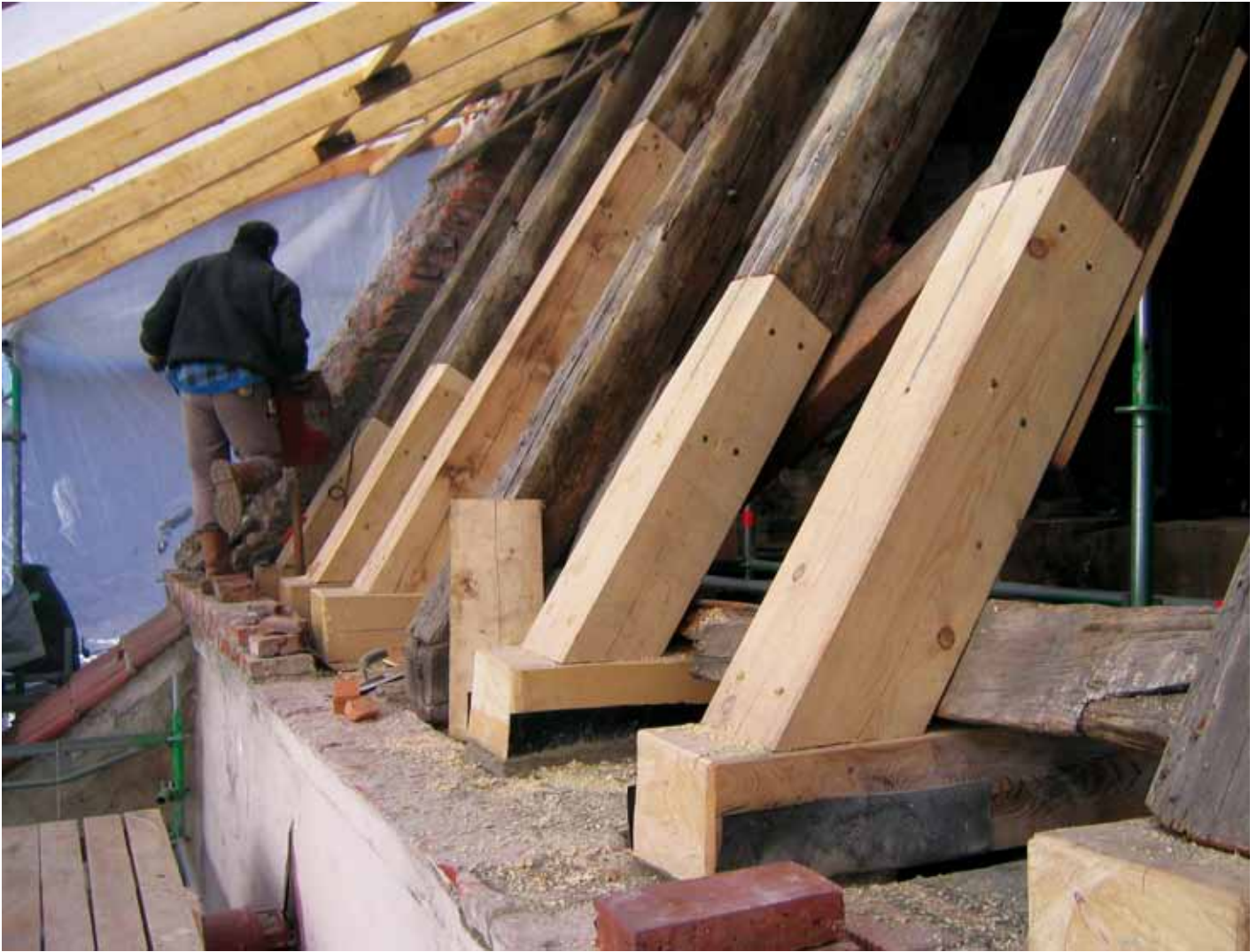
saniertes Dachfuß, Detail
