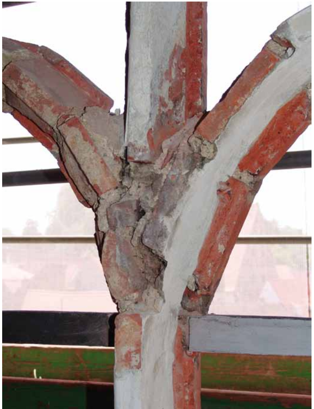
Abgängiges Maßwerk, Obergaden, Detail
