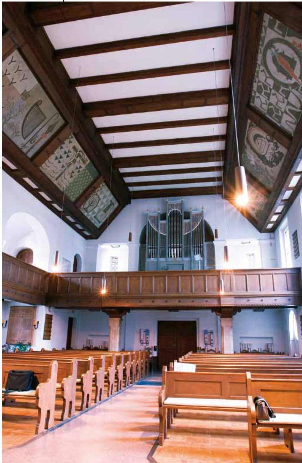
Der Innenraum gegen Osten vor der Renovierung, 2010
