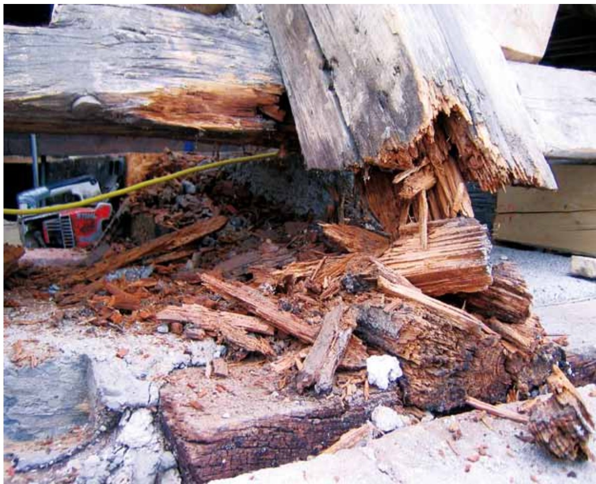
abgängiger Dachfuß, Detail
