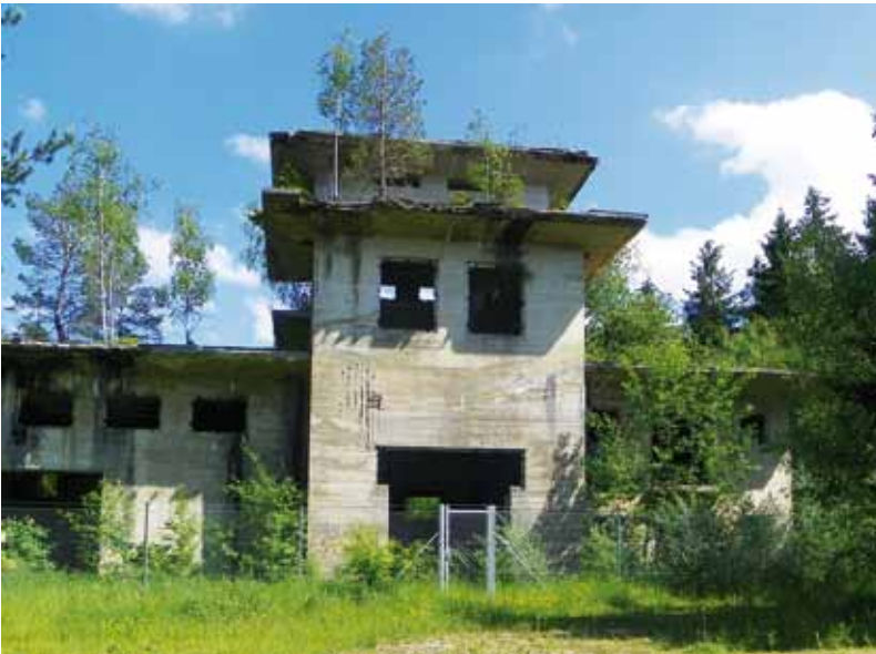
Abb. 4 Ganz im Norden des DAG-Geländes steht noch eine Stahlbetonruine: Gebäude Nr. 1 (526), in dem die Kesselwasseraufbereitung durchgeführt worden wäre.
