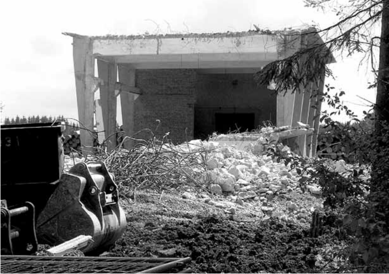
Abb. 3 Für das Großsägwerk der Fa. KlausnerHolz-Bayern wurde 2007 eine ganze Reihe von Gebäuden abgerissen, u. a. das Hallengebäude 356 auf diesem Foto vom 5. Juni 2007.
