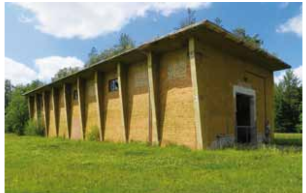
Abb. 7 Gebäude Nr. 3 (263) wird von der Stadt Landsberg als Lagerhalle verwendet. An den Außenmauern ist noch der grünliche Tarnanstrich aus dem Zweiten Weltkrieg zu erkennen.
