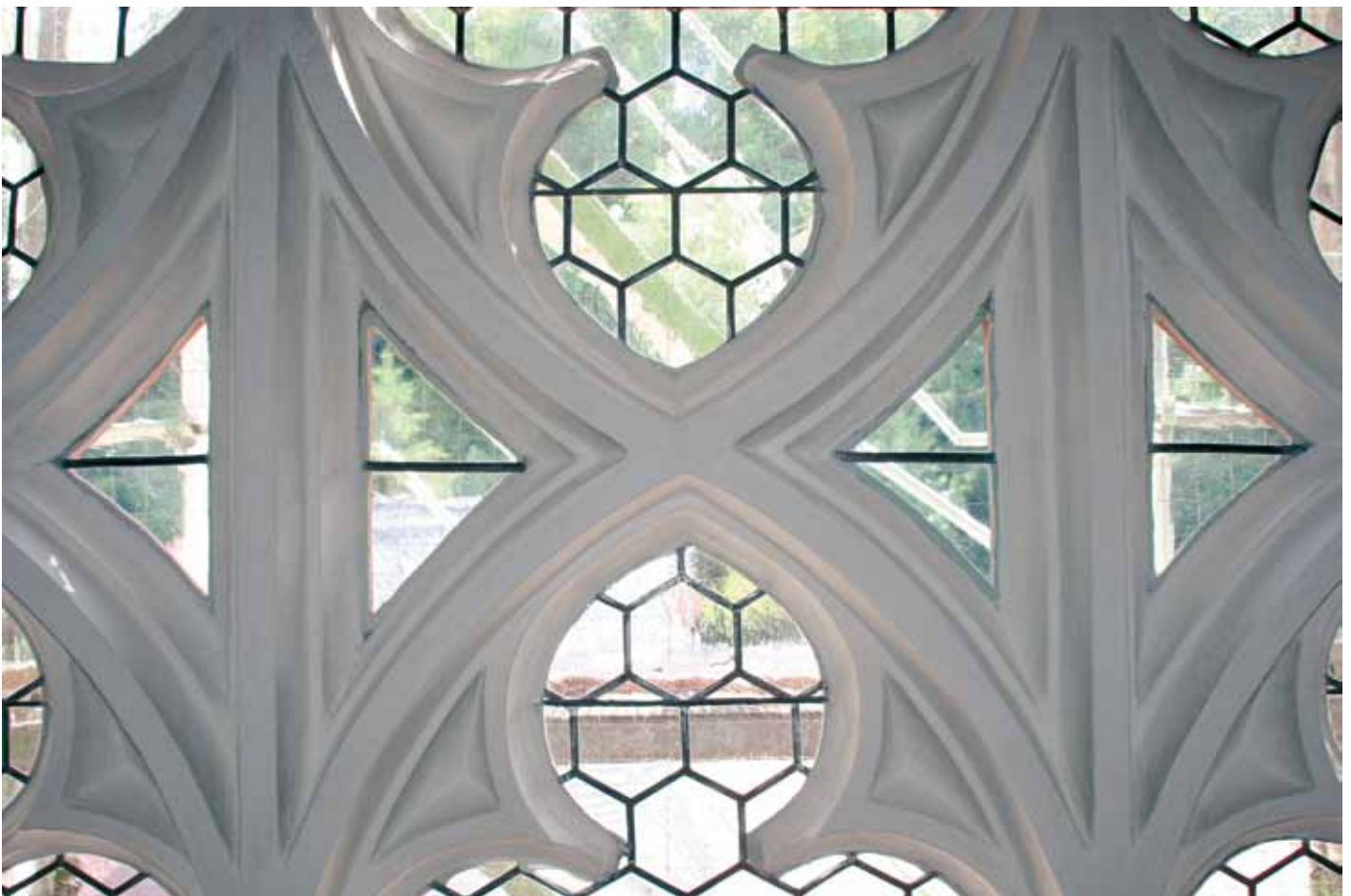
Saniertes Maßwerk, Detail
