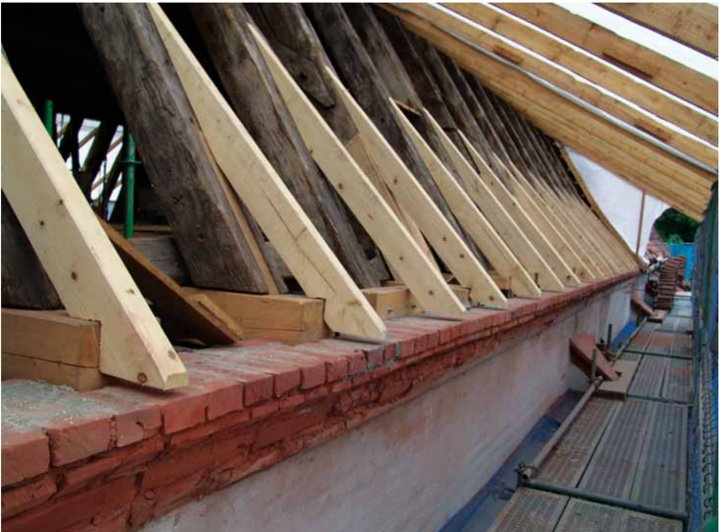
Saniertes Dachgesims, Detail
