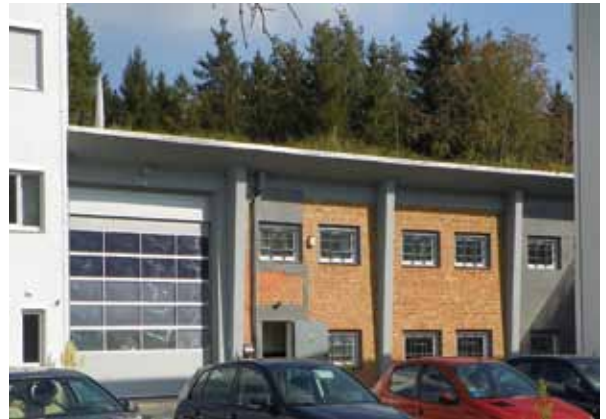
Abb. 6 In der Celsius-Straße ist das Äußere des Gebäudes mit der Nr. 14 (233) vom neuen Besitzer recht ansprechend umgestaltet worden. An die ehemalige DAG-Halle erinnert noch das begrünte Flachdach.
