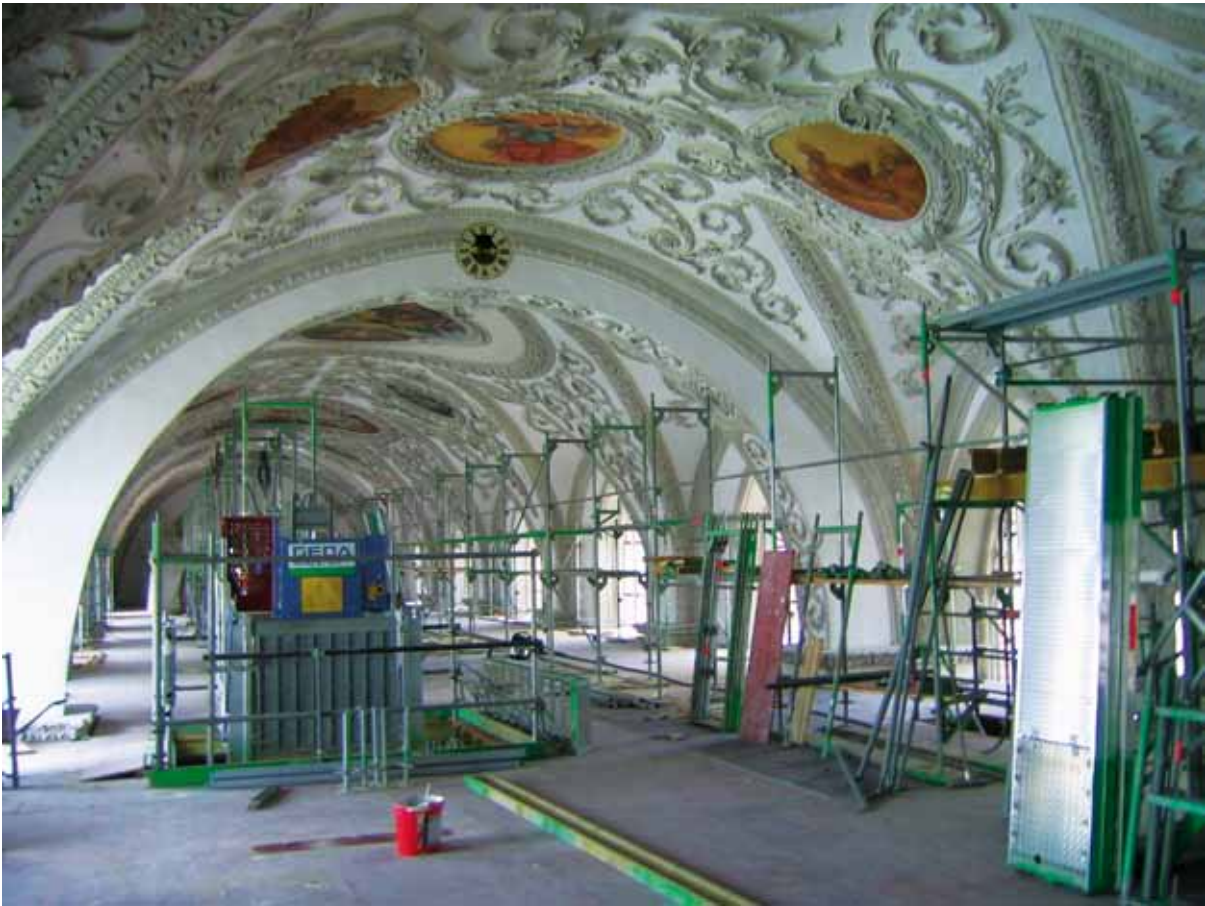
Arbeiten an der Decke des Hauptschiffs
