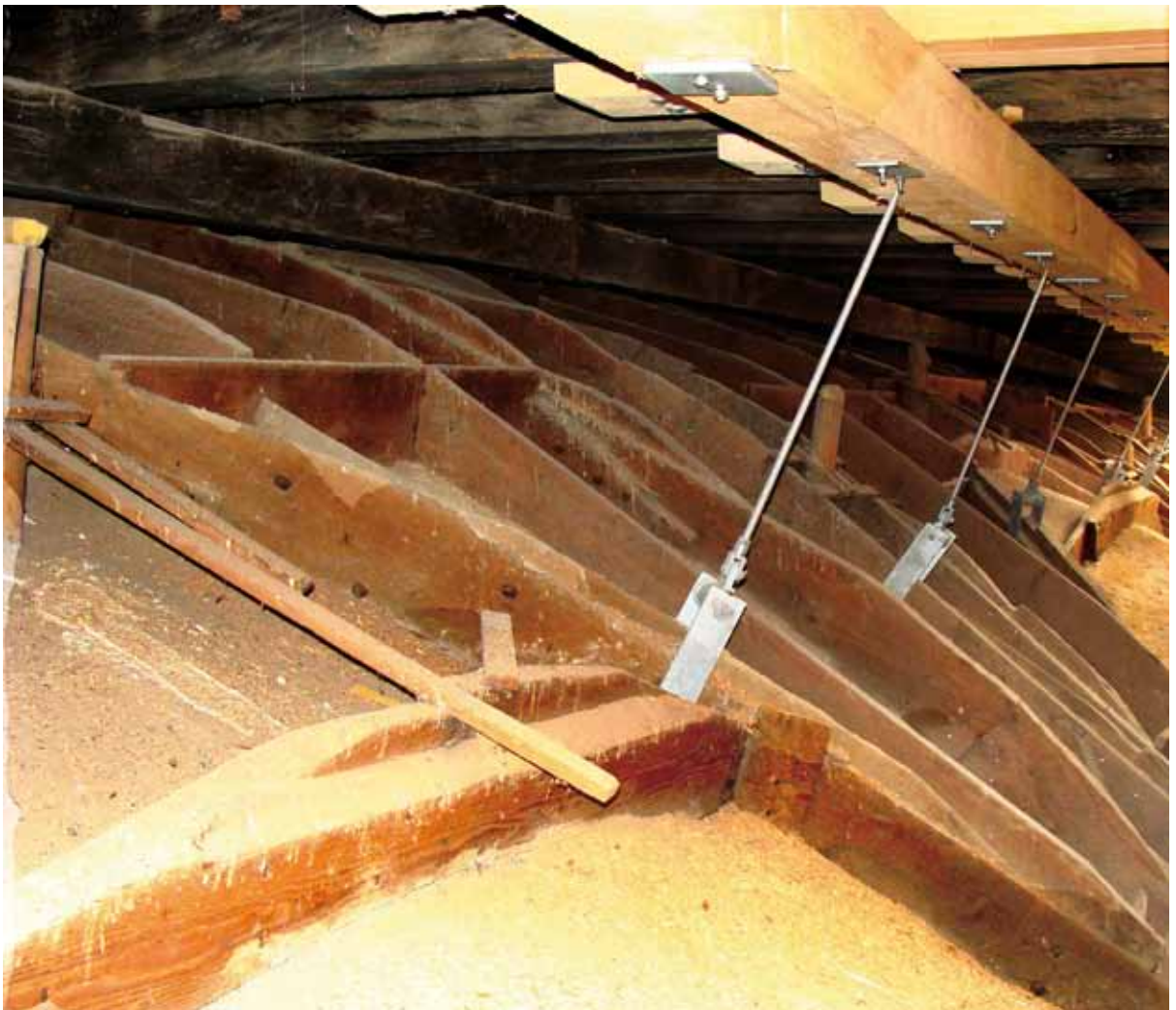
Raumschale Spannengewölbe, Abhängung
