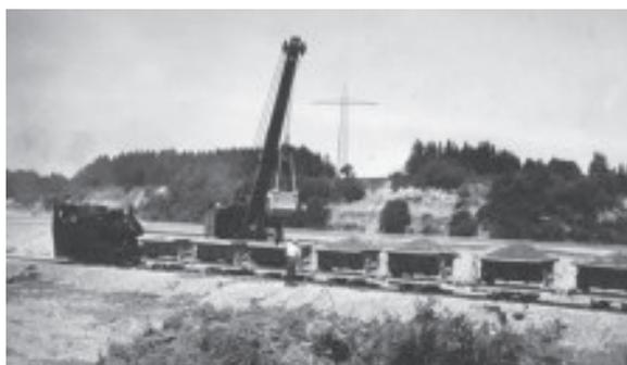
In großen Betonmischern, angetrieben von Dampfmaschinen, wurde der Beton hergestellt.<sup>90</sup> Für die Dampfmaschinen und für die Feldbahnen benötigte man sehr viel Kohle. Die Zeitzeugen erinnern sich an die großen Baumaschinen, an Kräne, Bagger und Schubraupen, aber auch daran, dass viel Handarbeit nötig war.
