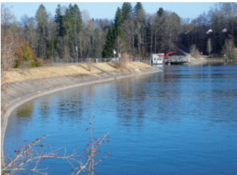
Stufe 9/Apfeldorf: westlicher Damm mit Betonsicherung (Foto A. Lichtenstern)
