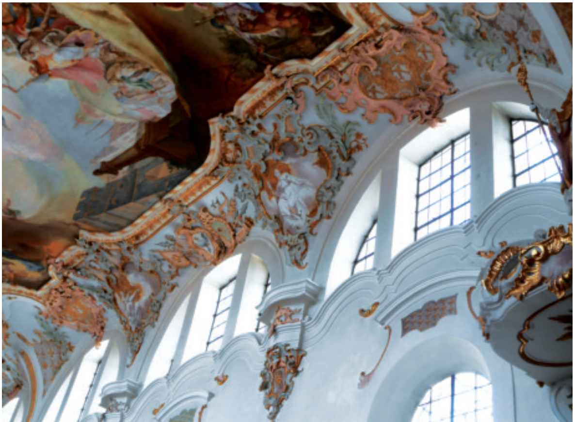
Abb. 7 St. Ulrich, Eresing, Innenansicht, Bogenfenster, Gewölbezwickel, Aufn. H. Bader, Windach
