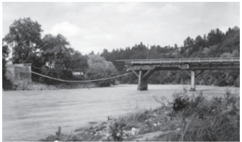
Abb. 2: Die zerstörte Sandauer Brücke 1945 (Bild: Stadtarchiv Landsberg)
