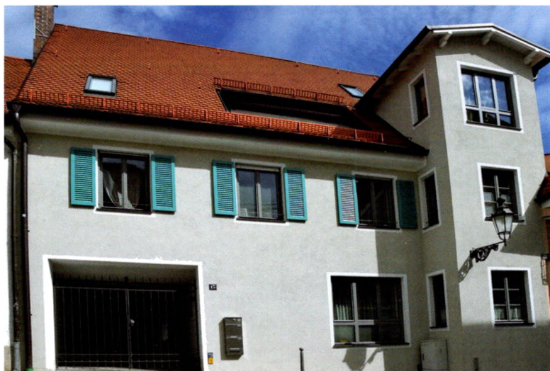
Abb. 3 Adam Luidl hatte in der Wieneringstraße 15 (alte Hausnr. 66) in Dachau seine Bildhauerwerkstatt (Ansicht 2020).
