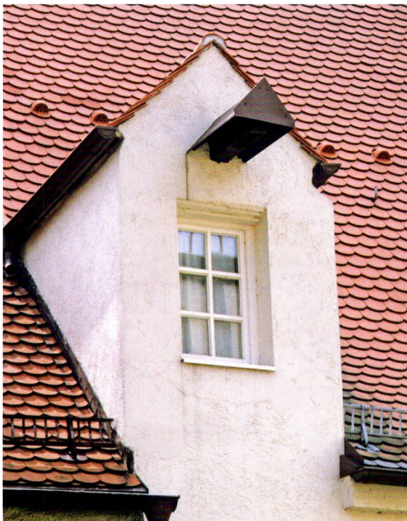
Abb. 22 Die Rolle für den Lastenaufzug im Dachgeschoss
