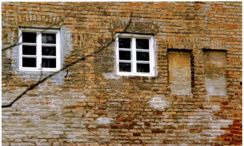
Abb. 11 Vereinheitlichte Westfront von Klösterl 67 bis 70 (oben) mit späterer Erhöhung der Fensterleibungen bei Klösterl 67 (unten).
