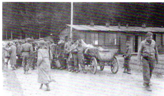
Abb. 5 NS-Truppen errichten vor der Baracke des Kommandeurs einen Verpflegungspunkt für die in den Baracken wohnenden befreiten KZ-Häftlinge.
