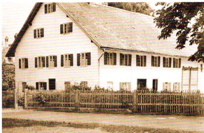
Abb. 10 Beim Gerlebauer 1935, Foto: Ortschronik Ober- und Unterigling, 2009
