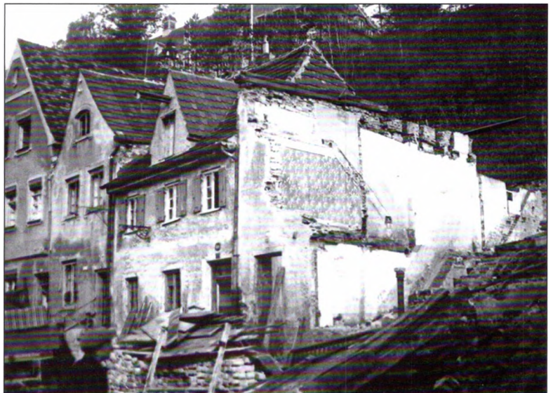
Abb. 15 Wegen des Baus der Neuen Bergstraße beiseitigte Häuser des Seelbergs über dem Klösterl zu Beginn der Abrissarbeiten ca. 1934/35, Stadtarchiv Landsberg
