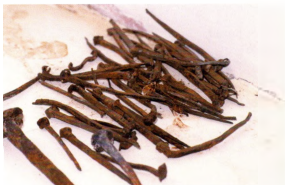
Abb. 6 u 7 Holznägel und handgeschmiedete Eisennägel, die beim Bodenlegen früher verwendet wurden
