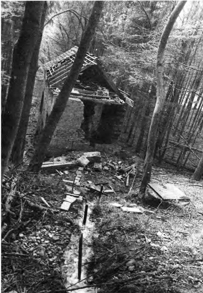
*Im Jahr 1858 wurde dieses Pumpenhaus in der Pössinger Au erbaut und am 11. Mai 1987 zerstört angetroffen. Noch am 30. April 1987 war dieses Gebäude bis auf die nördliche Dachfläche, die kleine Schäden aufwies, intakt; das Mauerwerk in Tuff und Ziegel geschlossen.*
