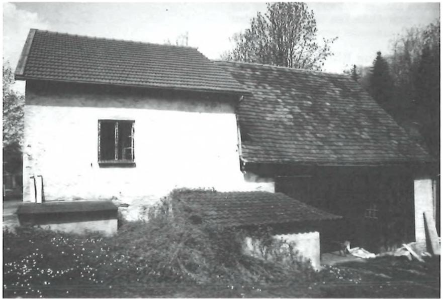
Abb. 5: Heutiger Zustand des ehemaligen Kalkofens an der Schwaighofstraße; im Untergeschoß des linken Gebäudeteils befand sich der Kalkofen, von der links anschließenden Rampe aus wurde er gefüllt.
