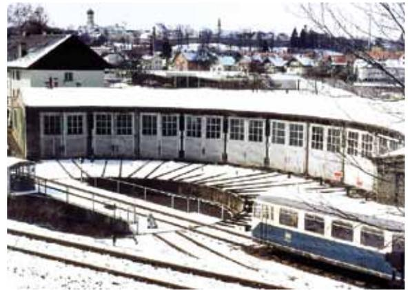
*Abb. 5 Bw Schongau mit Ringlokschuppen und Drehscheibe, rechts unten im Bild ein abgestellter Triebwagen ETA 150 (1982)*
