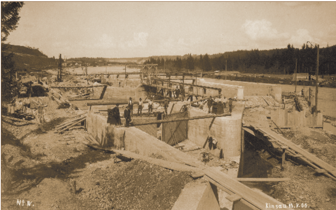
Abb. 7 Foto 11. 5. 1906 Arbeiten an der Kiesschleuse und am Ostufer
