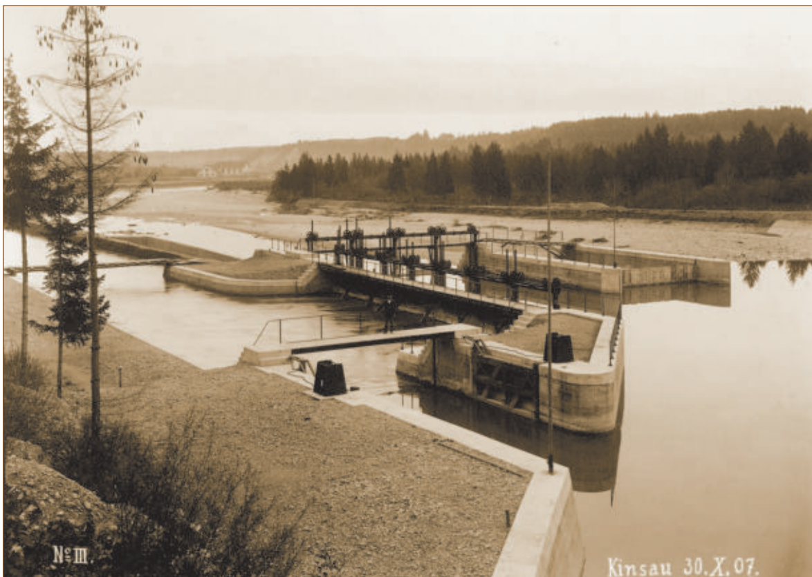
Abb. 11 Foto 30. 10. 1907 Einlaufbauwerk mit Floßschleuse, Wehr mit Kiesablass und Floßgasse; Blick nach Norden
