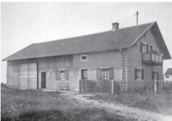
Abb. 2 Ortseingang von Penzing. Vor diesem Haus verläuft die Staatsstraße nach Schwabhausen.
