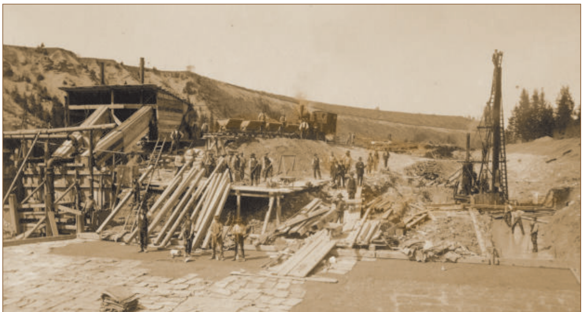
Abb. 6 Foto 11. 5. 1906 Baugrube für das Krafthaus (Turbinenhaus)
