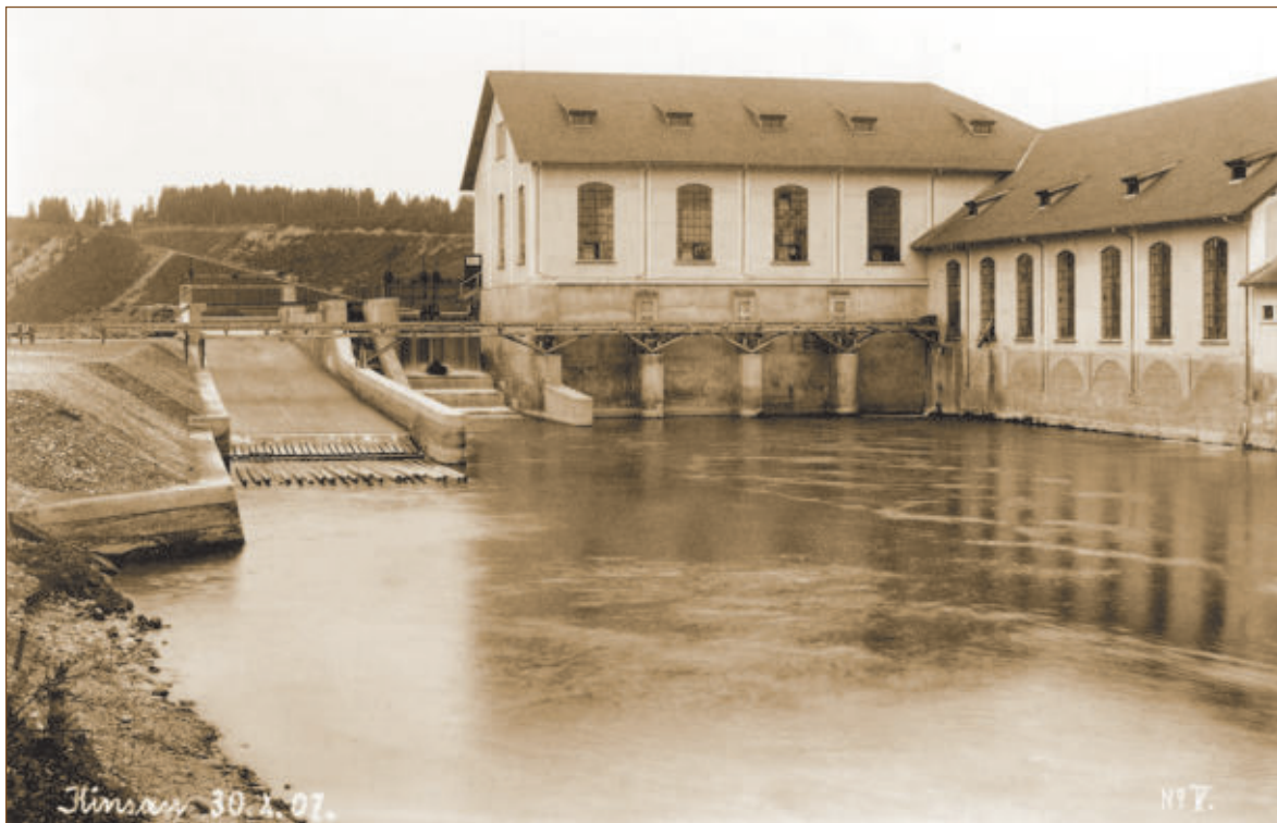
Abb. 14 Foto 30. 10. 1907 Blick von Norden, vom Unterwasser aus, auf das Krafthaus und die Fabrik; gut erkennbar ist am Leerschuss die Fallhöhe des Kraftwerks, links daneben die Flossgasse.
