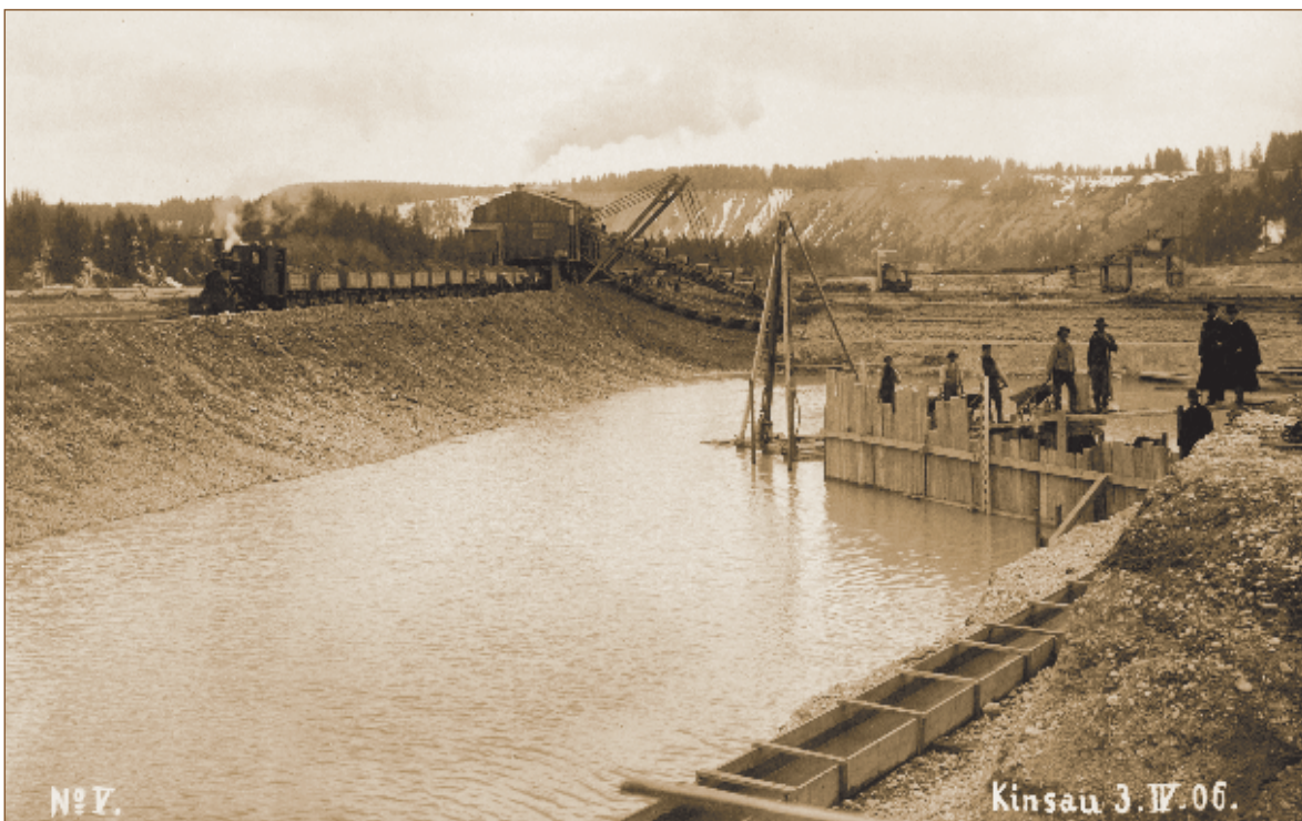
Abb. 4 Foto 3. 4. 1906 Aushubarbeit für den Werkkanal. Blick nach Süden. Zu erkennen sind links auf dem Damm eine Werkbahn und ein Eimerkettenbagger.
