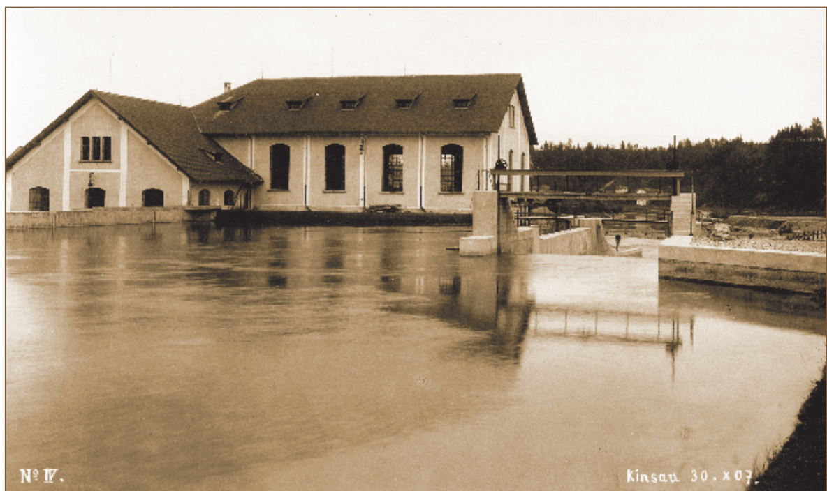
Abb. 13 Foto 30. 10. 1907 Blick von Süden, vom Oberwasser, auf das Kraftwerk mit der Schleiferei (rechts), daneben der Leerschuss und die Floßgasse
