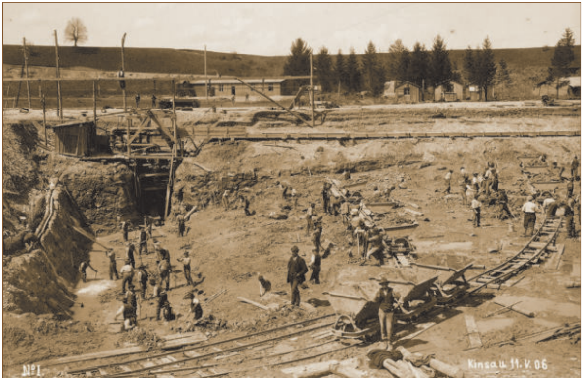
Abb. 5 Foto 11. 5. 1906 Baugrube für das Fabrikgebäude
