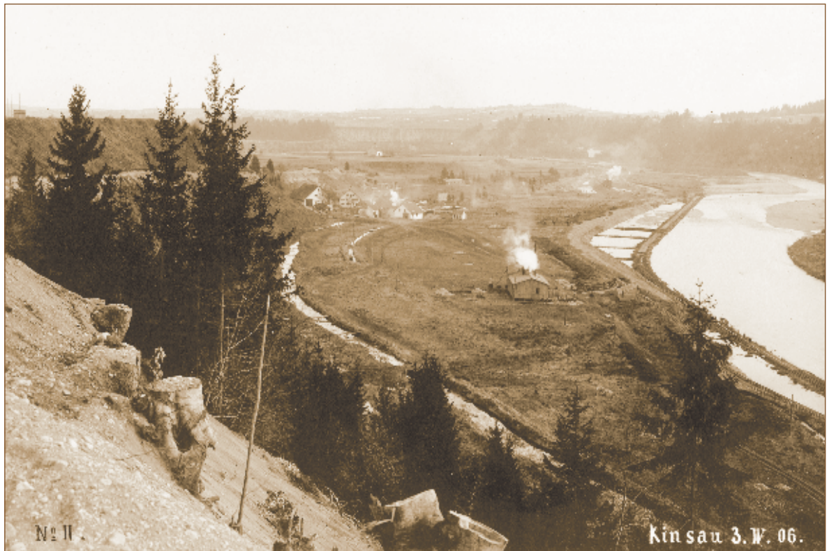
Abb. 1 Foto 3. 4. 1906 Blick nach Norden. Alte Sägemühle und Mühlbach
