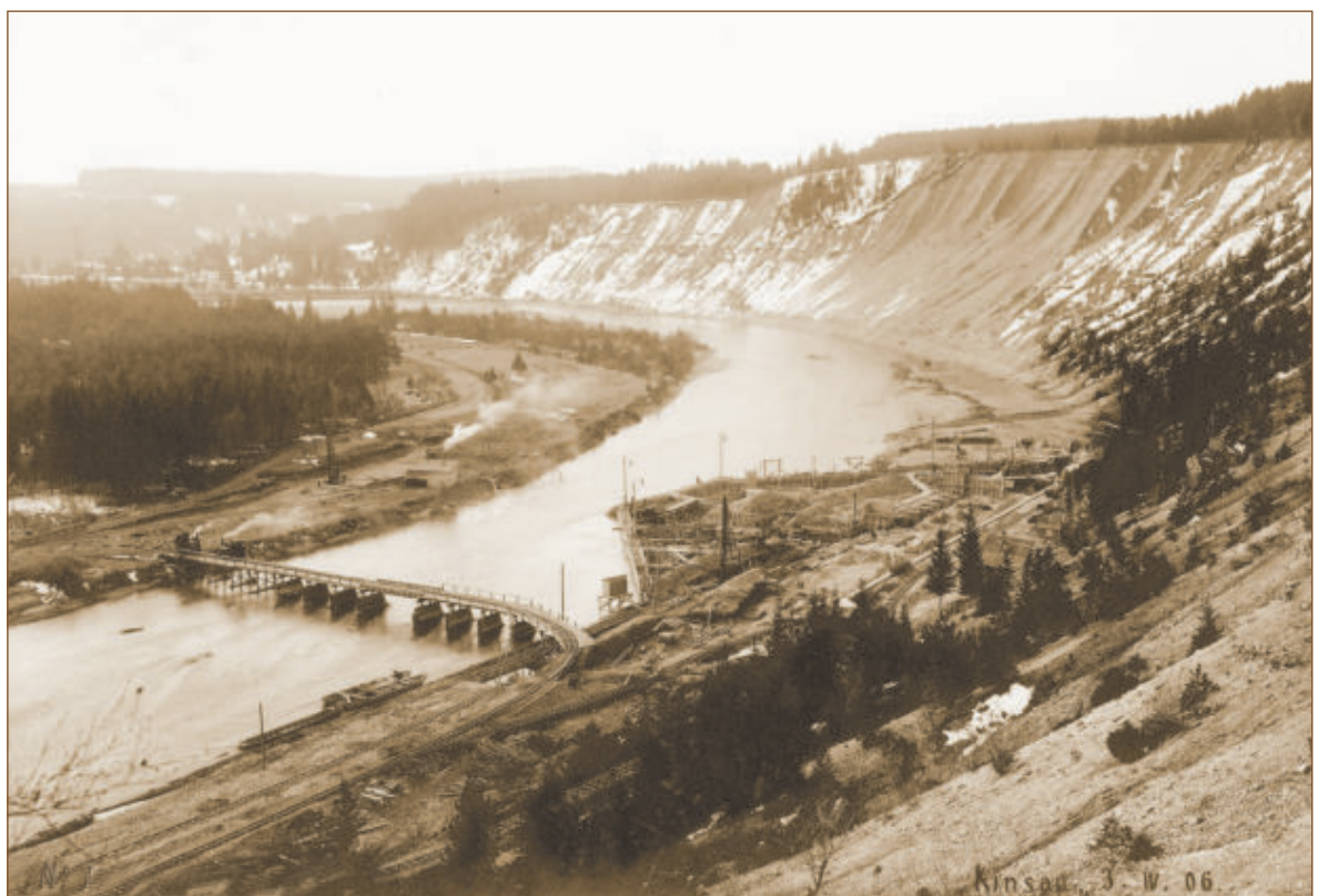
Abb. 2 Foto 3. 4. 1906 Blick nach Süden. Oberhalb der Arbeitsbrücke (mit Floßdurchfahrt) rechts die Baustelle für den Einlauf des Werkkanals, der Floßgasse und der Kiesschleuse
