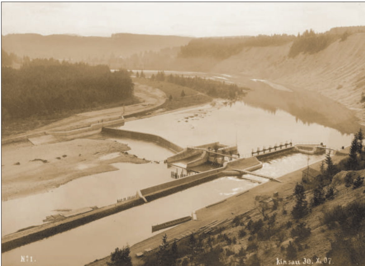
Abb. 10 Foto vom 30. 10. 1907 Wehr, Floßgasse, Kiesschleuse, Werkskanal; Blick nach Süden
