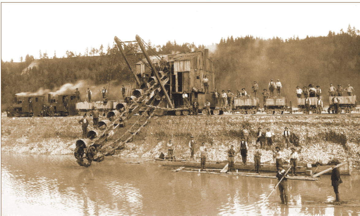
Abb. 8 Foto 11. 5. 1906 Eimerkettenbagger und Werkbahn, wohl bei der Aufschüttung des Werkkanals
