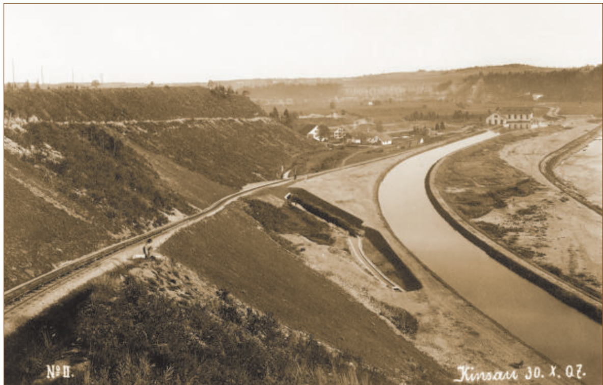
Abb. 12 Foto 30. 10. 1907 Blick nach Norden auf den Werkskanal und die Fabrik, links am Hang die Trasse der Zahnradbahn
