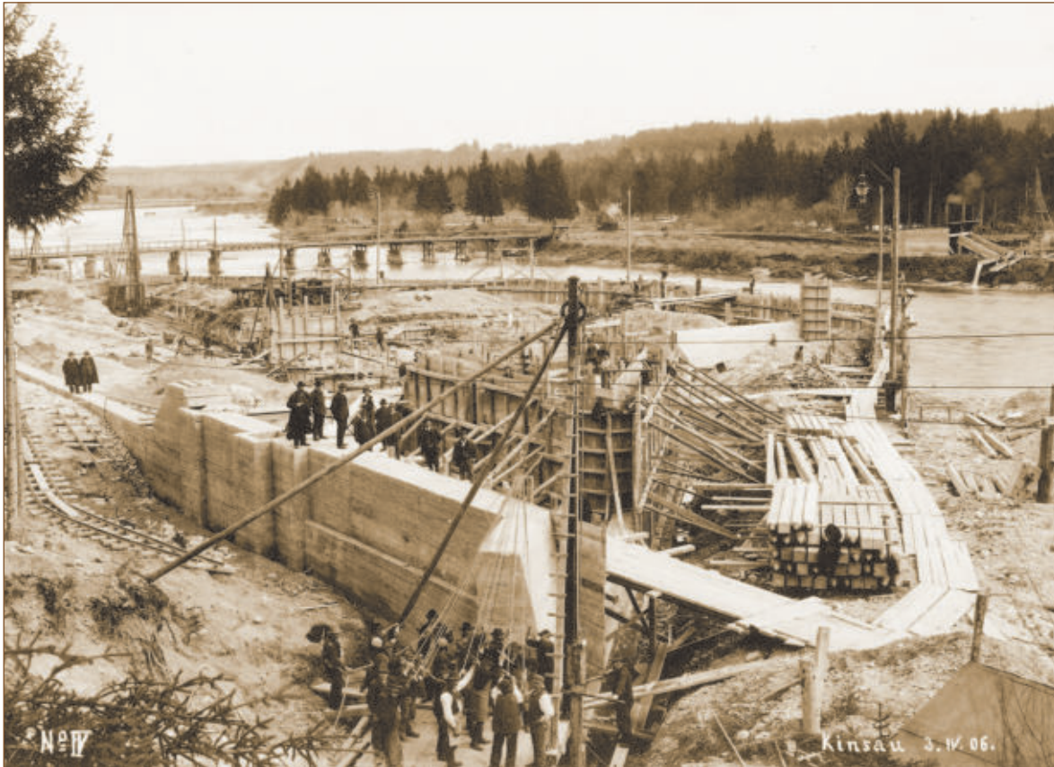
Abb. 3 Foto 3. 4. 1906 Baustelle für den Einlauf des Werkkanals. Blick nach Norden
